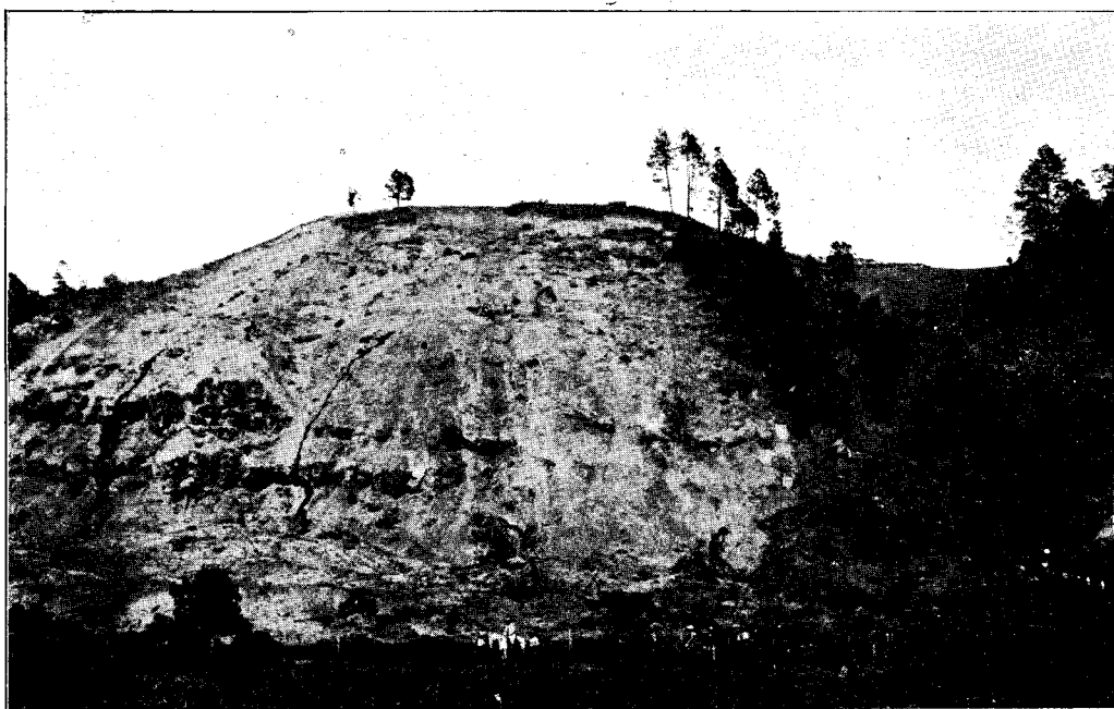
Fotografía número 2.—Derrumbe del terreno blando en el cerro de “La Fundición,” que descubrió el esqueleto basáltico de la montaña y provocó el alumbramiento de manantiales.
