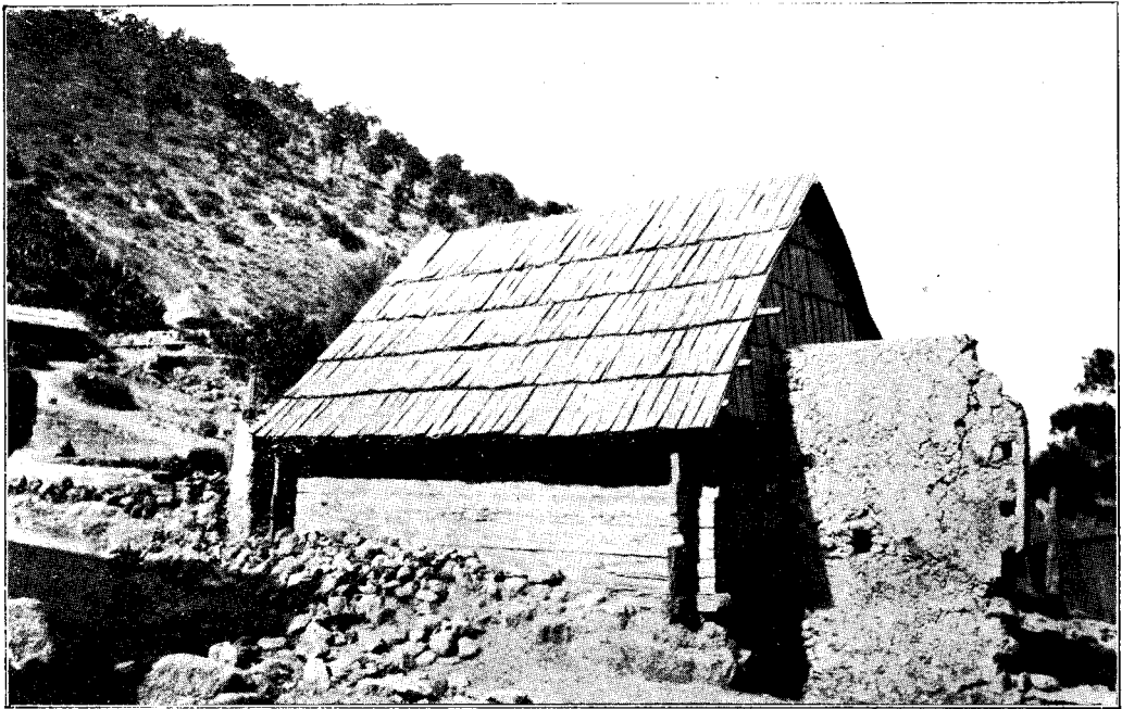
Fotografía número 1.—Casa de madera perfectamente conservada después del terremoto. Saltillo Lafragua.
