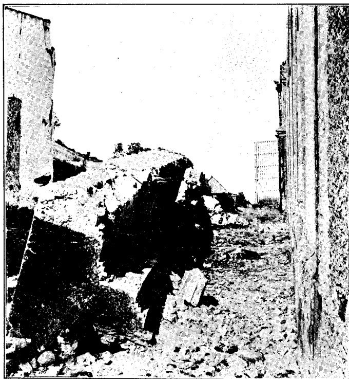
Fotografía número 2.—Detalle de la cornisa: altura, 1.50; espesor medio, 0.63; longitud, 18.00 metros. Distancia del centro de gravedad del bloque caído al muro, 1.70. Altura del muro, 5.00 metros.
