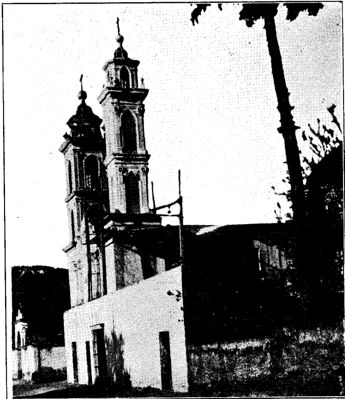
Fotografía número 2.—Iglesia de Guadalupe, San Andrés Chalchicomula. Fachada orientada al W. Fracturas en el costado sur de la torre sur.
