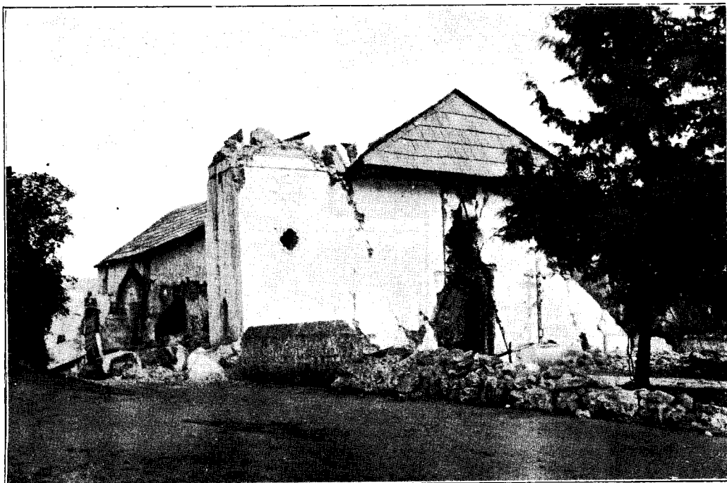
Fotografía número 1.—Iglesia de Chilchotla, Pue. Fachada al W. Caída de la torre al NE.
