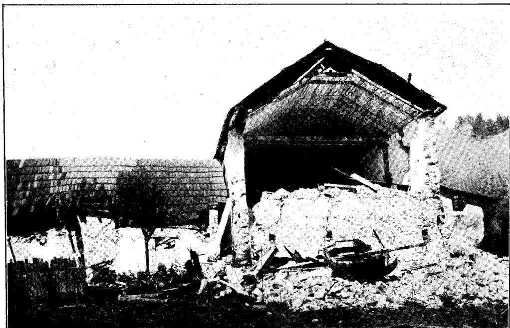
Fotografía número 2.—Muro posterior de la iglesia de Chilchotla, Pue. Caída de la parte alta del Ciprés al E.
