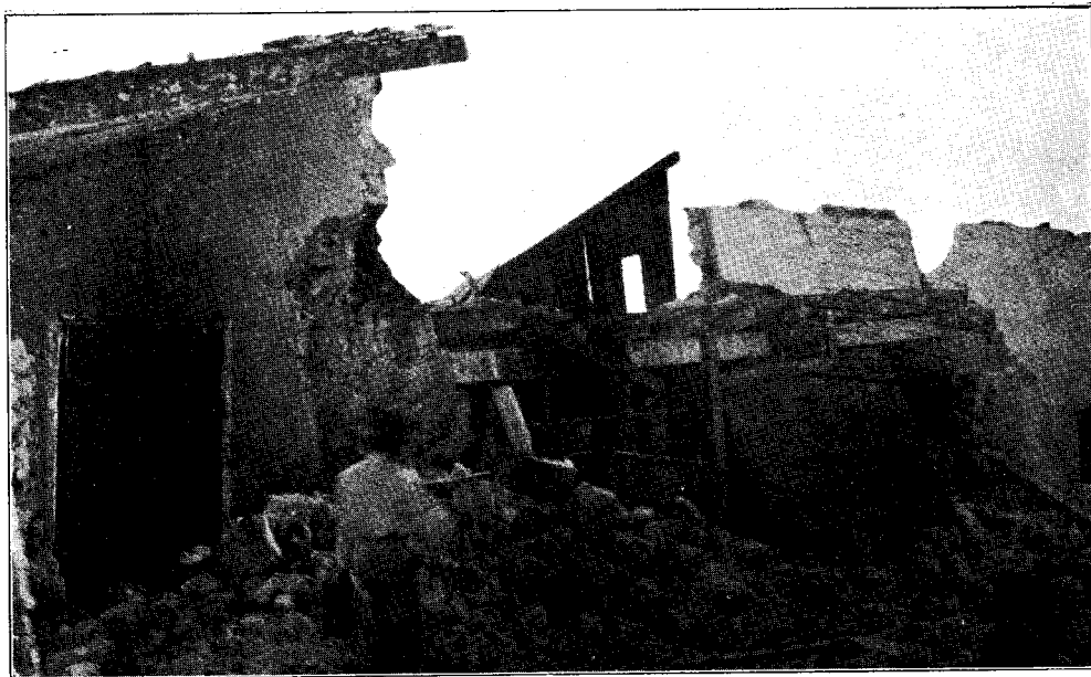
Fotografía número 4.—Casas destruídas en la calle de Leona Vicario, Jalapa, Ver.
