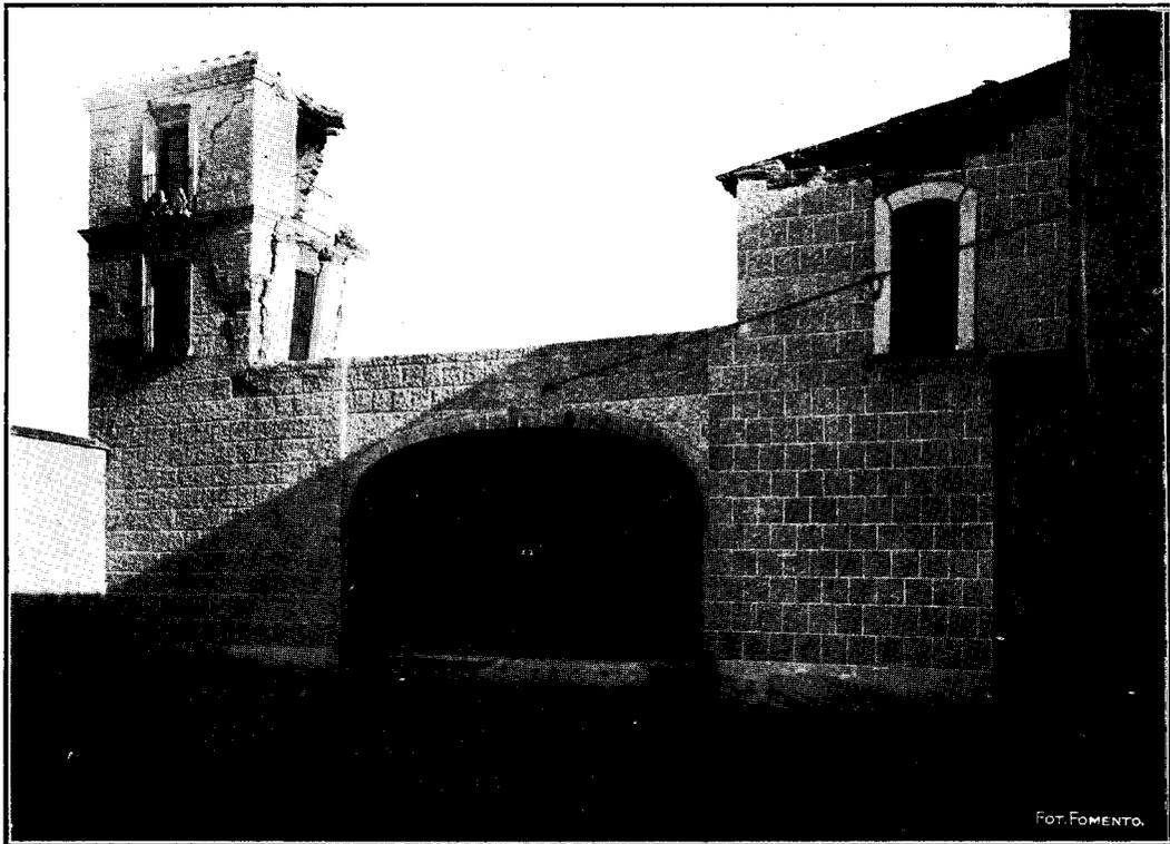
Fig. 88.—Colegio católico para niñas en Temascalcingo. Efectos del temblor en el segundo y tercer piso del torreón
