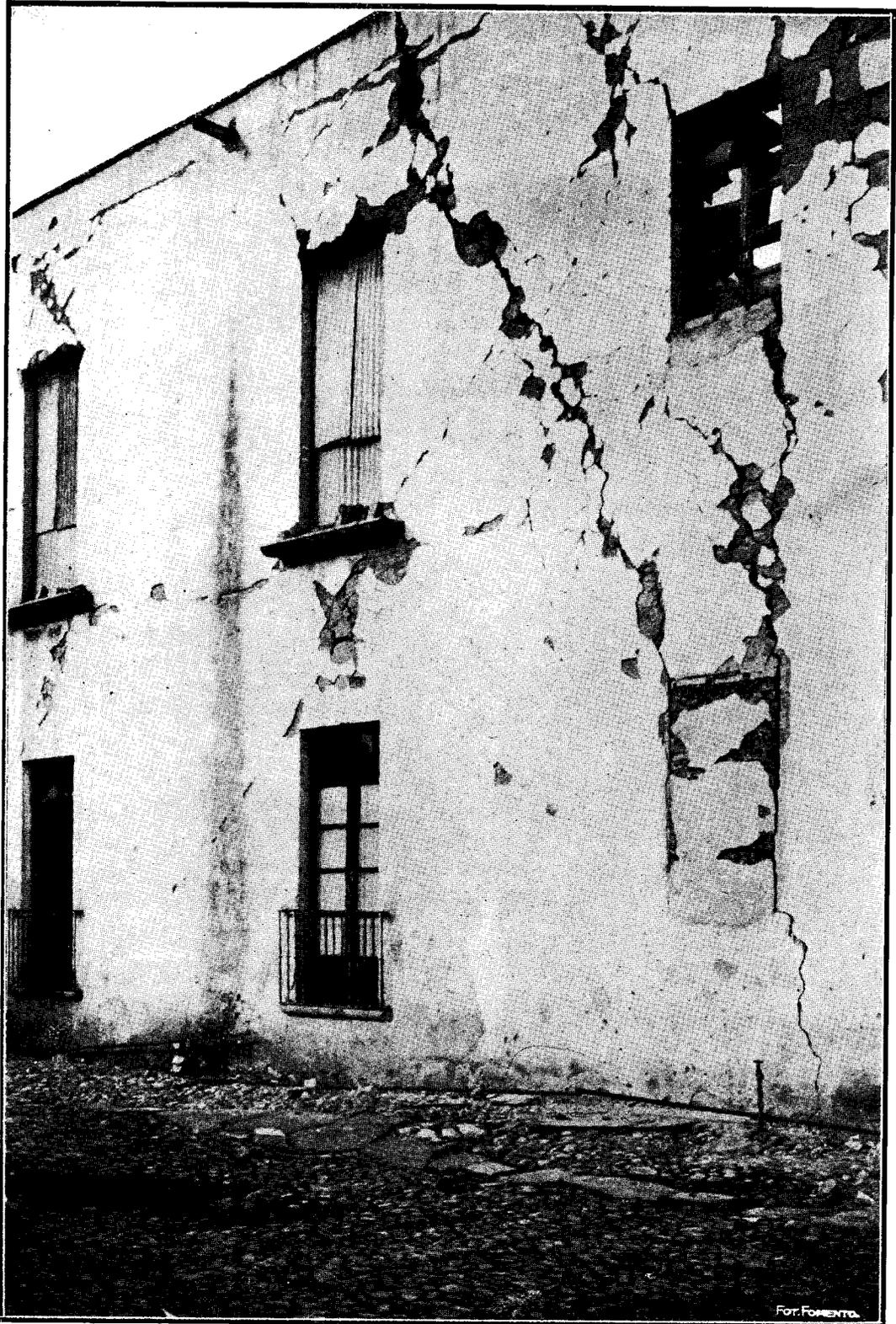
Fig. 75.—Muro que ve al Oriente de la casa de la hacienda de Toxi. Desprendimiento de los cerramientos de las ventanas superiores y posición de las cuarteaduras.
