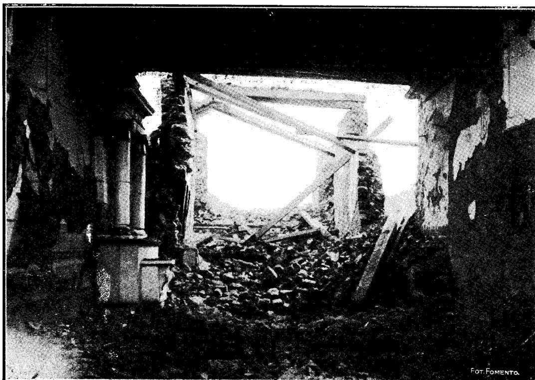
Fig. 70.—Restos de la iglesia de San Pedro el Alto (cámara afocada al E.). El muro del Norte aparece notablemente doblado hacia el Sur; y los dislocamientos de las columnas del altar lateral demuestran la dirección N.-S. del movimiento.
