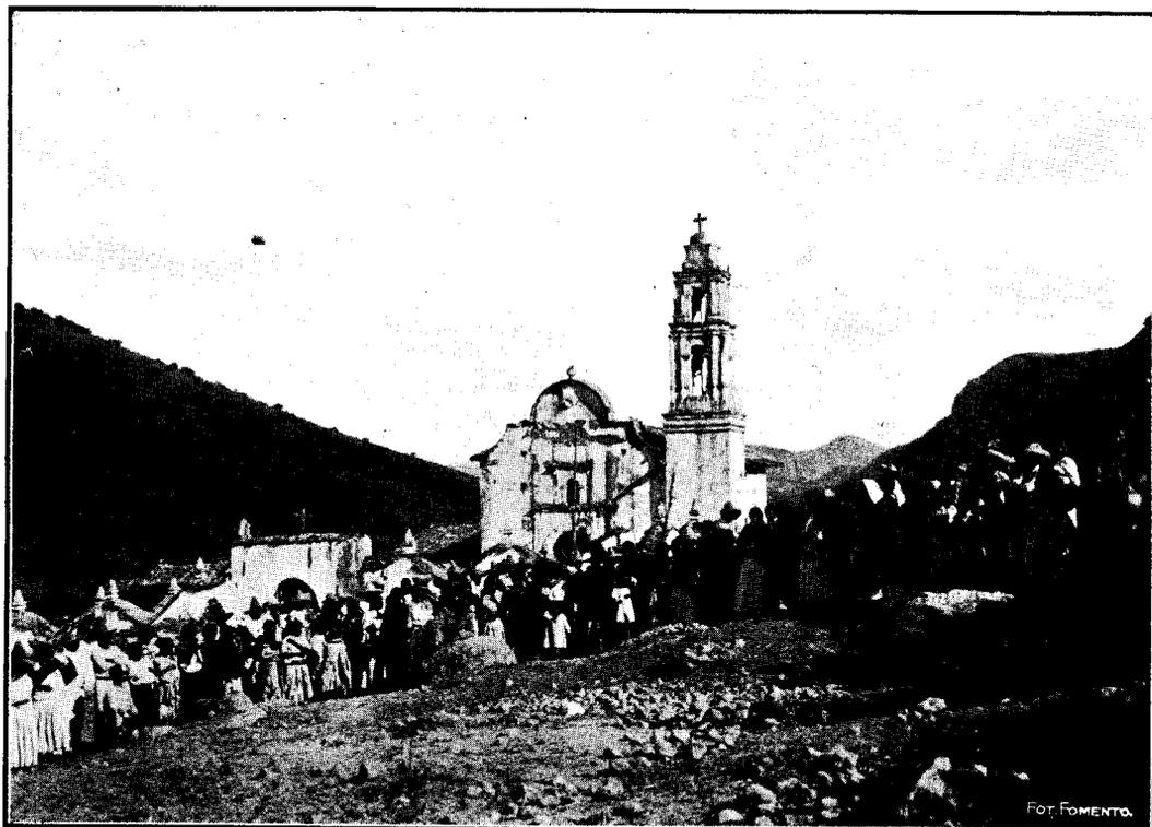
Fig. 78.—Iglesia del pueblo de San Pedro Potla. Las columnas del segundo cuerpo de la torre indican la dirección del impulso más intenso. (Cámara afocada al Oriente).
