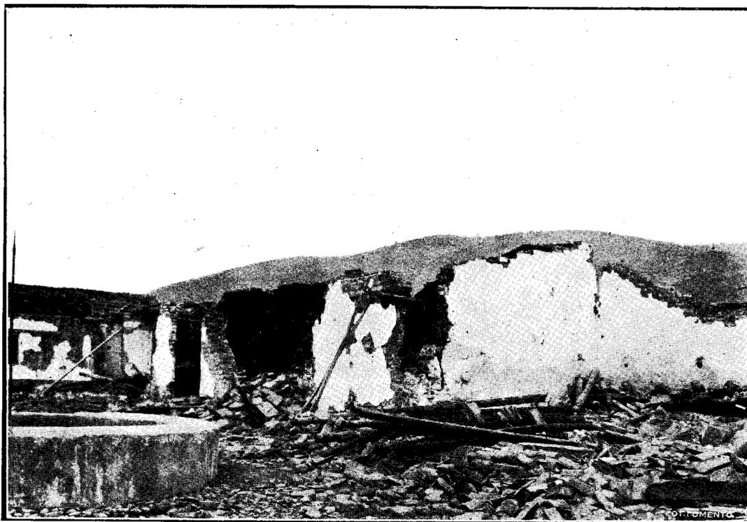
Fig. 72.—Destrucción completa de los muros Oriente-Poniente y conservación de los apañados de Norte a Sur en las habitaciones bajas de la hacienda de Toxi.
