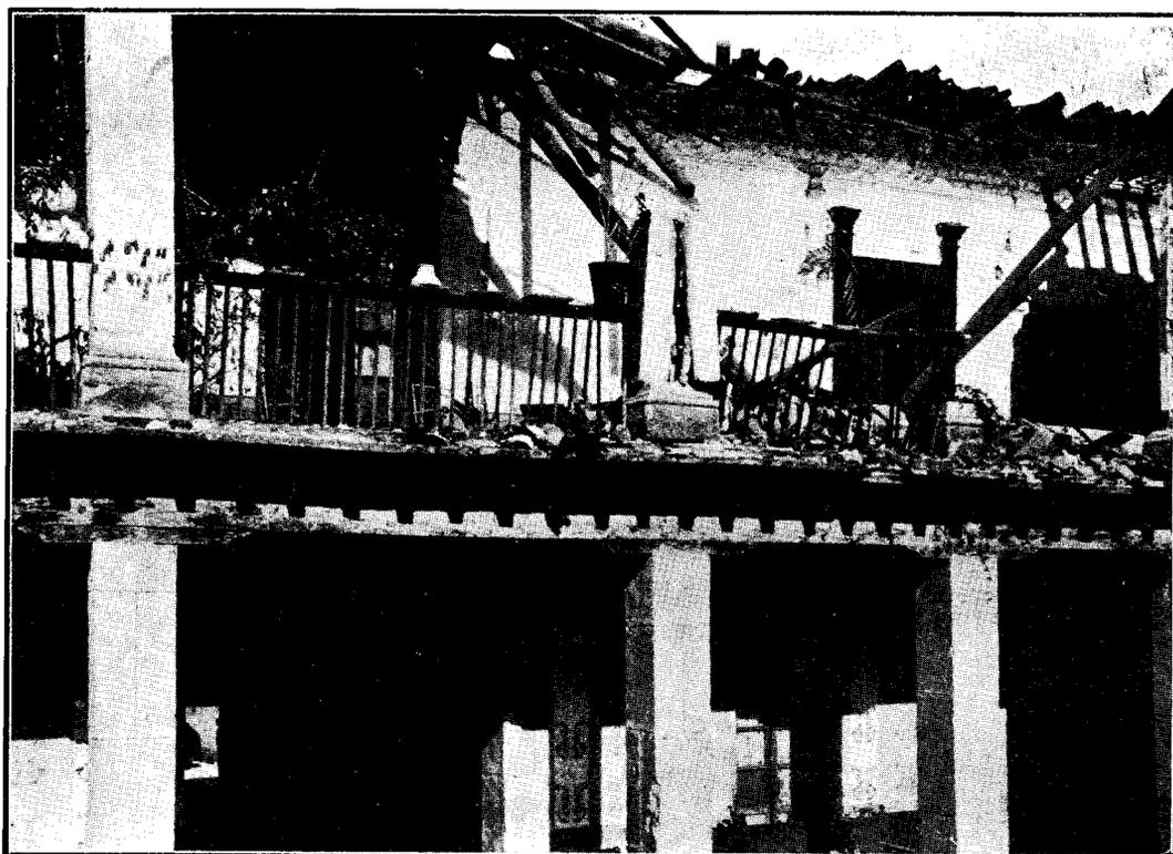
Fig. 69.—Corredor del segundo piso del curato de Temascalcingo con vista hacia el Oriente; los restos de una de las pilastras demuestran la dirección del movimiento.
