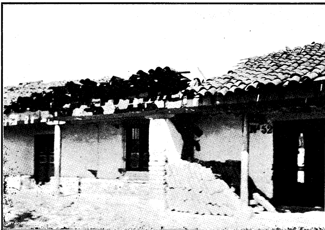
Fig. 63.—Casa contigua a la anterior, que muestra un grado mayor de destrucción del tapanco hacia el mismo rumbo. En ambas fotografías se han conservado los portales.
