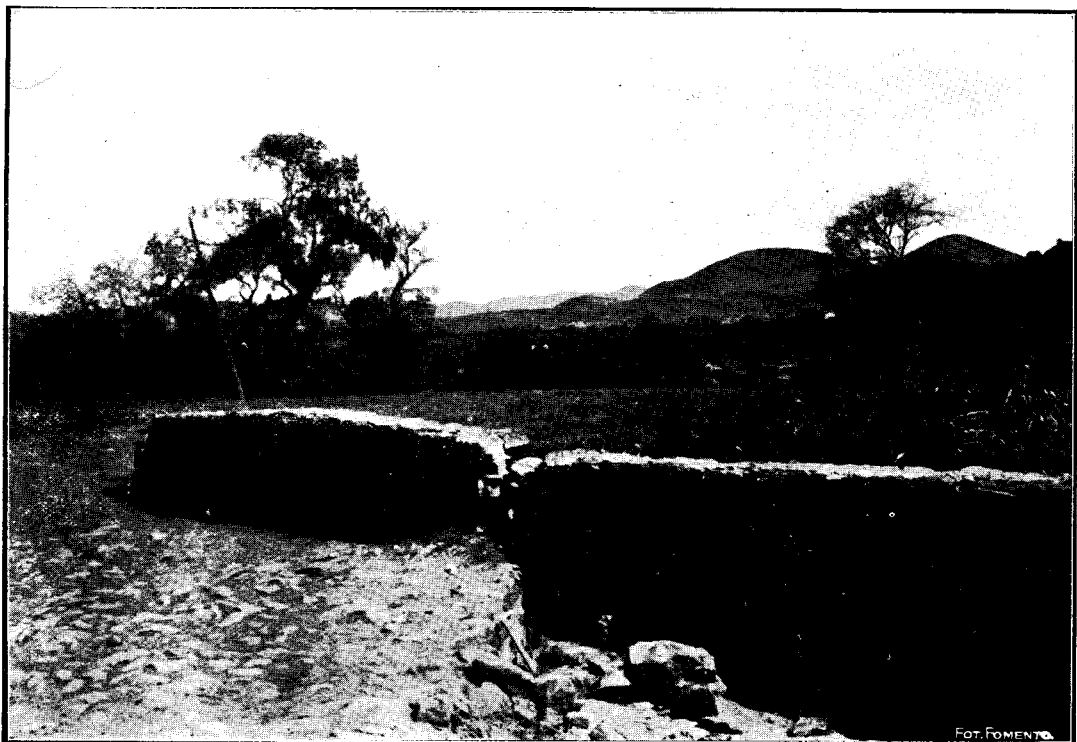
Fig. 37.—Efecto del hundimiento mencionado sobre el "Puente Grande"
