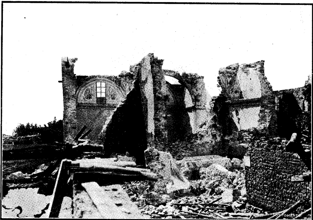
Fig. 53.—Ruinas de la iglesia de Acambay; conservación de los muros también apañados N.-S. y del costado meridional. El lado Norte y una parte del lado oriental cayeron en una sola pieza hacia el Norte.
