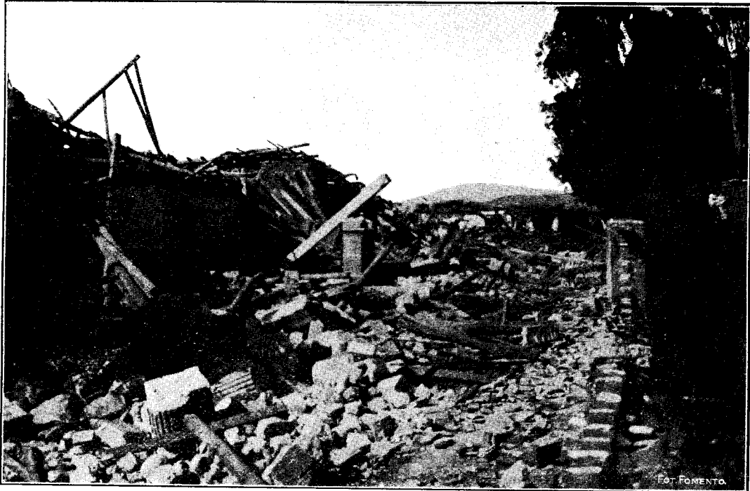
Fig. 50.—Aspecto de la calle situada en el costado Sur del atrio de la iglesia, orientada de E. a W. Destrucciones al N. de los portales de cantería.
