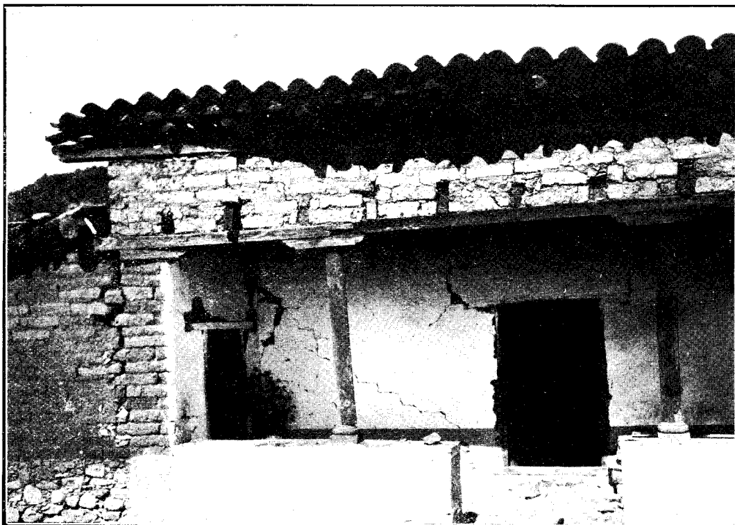
Fig. 62.—Fachada que ve al S. de una casa de la calle de Colón, en Acambay. Conservación del portal; inflexión del pretil del tapanco hacia el N. y dislocamiento de la columna de la izquierda abajo de la inflexión.
