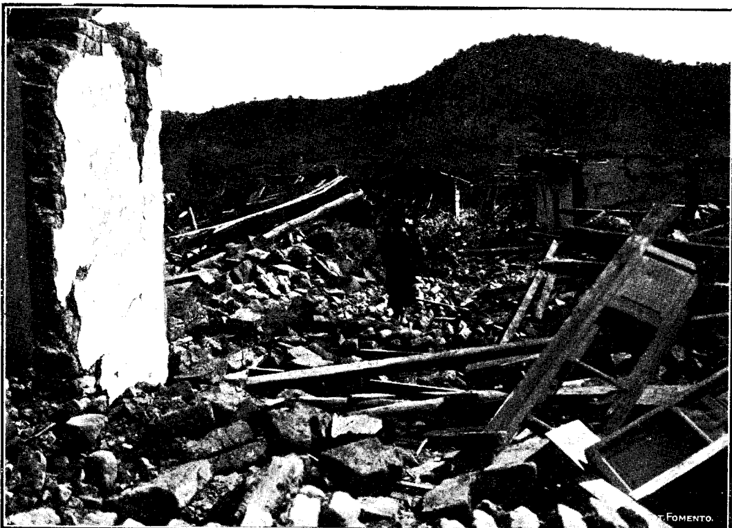
Fig. 49.—Calle Morelos, de Acambay, orientada de E. a W., obstruída por los escombros
