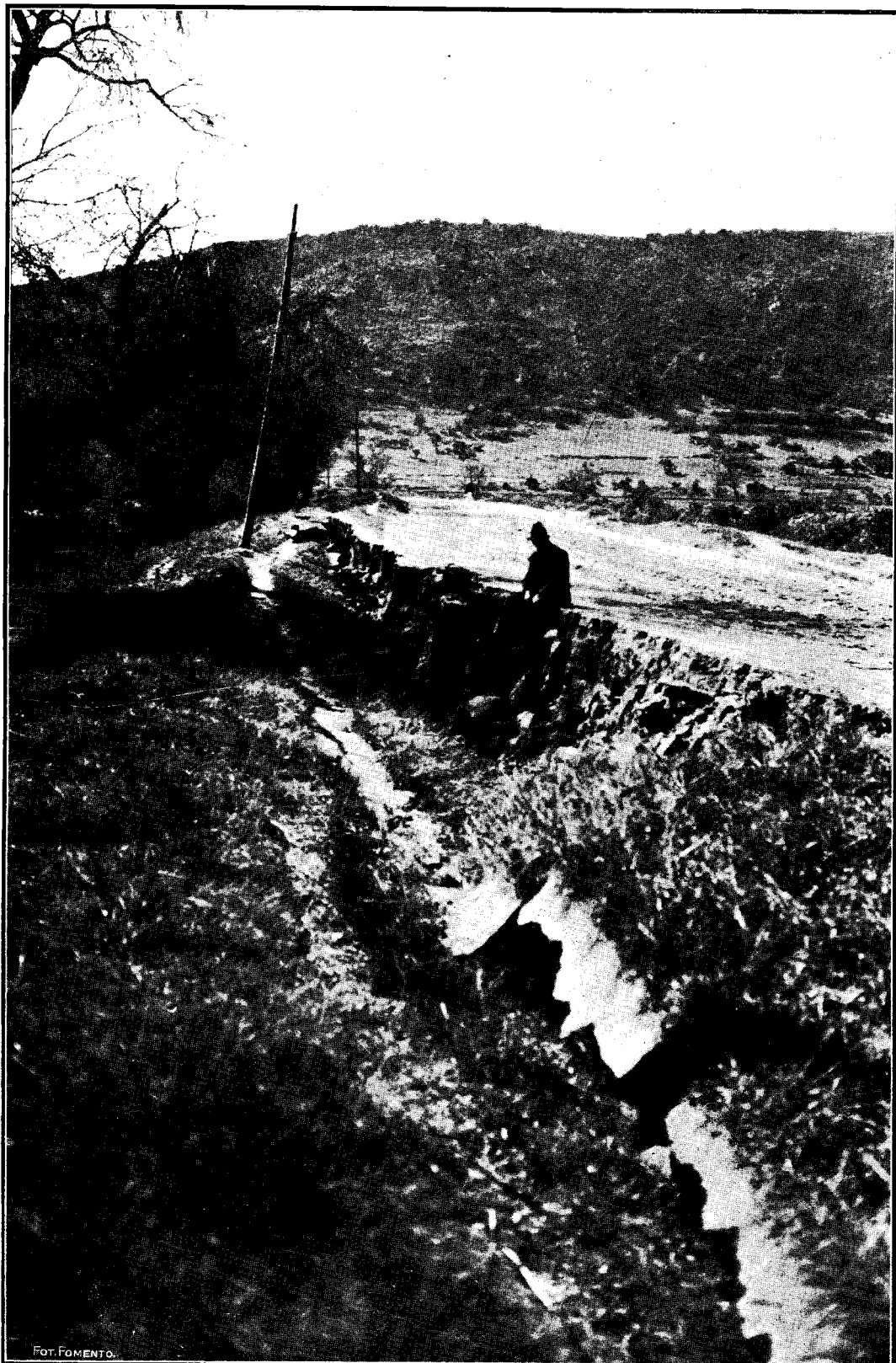
Fig. 42.—Agrietamiento y hundimiento con derrumbe parcial de los bordes, producidos entre el borde del camino y la margen derecha del mismo río.
