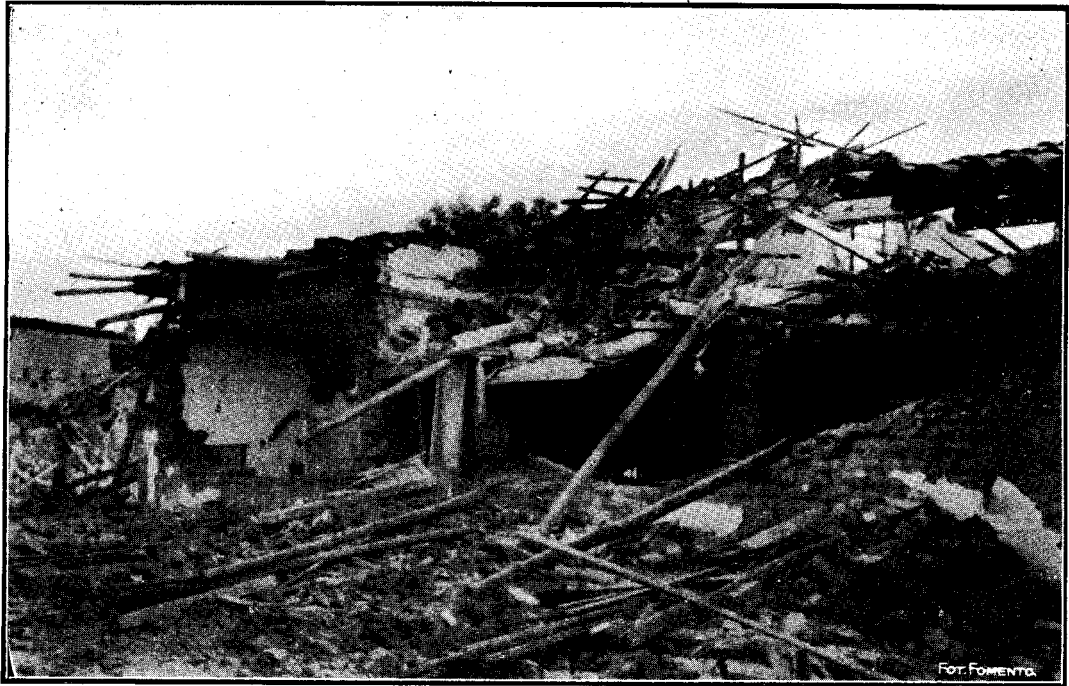
Fig. 60.—Calle de Cuauhtémoc, de Acambay, orientada de E. a W.; fachadas de la acera que ve al Norte, caídas hacia ese rumbo. Destrucción completa hacia ese rumbo.
