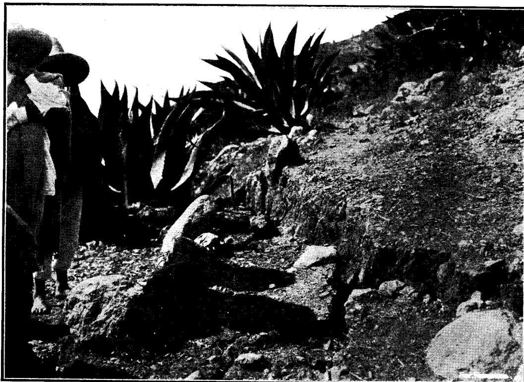
Fig. 28.—La grieta del sistema septentrional que pasa por la falda meridional del cerro "Tixmadeje," la más cercana al pueblo del mismo nombre, con desnivel de 50 cm., en terreno inclinado 30°.
