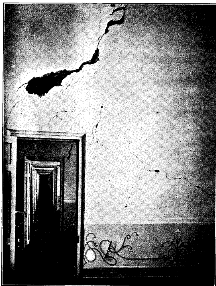
Manicomio de Zapopan. El muro maestro a la derecha (N.) está colocado sobre el terraplenado artificial
