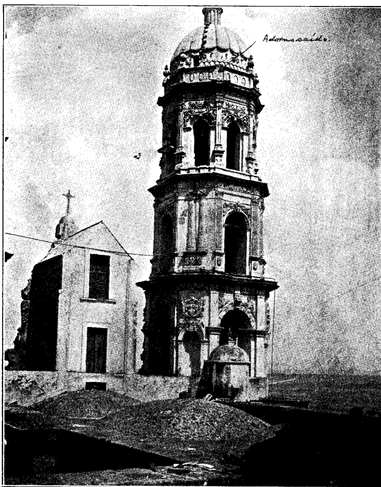
Torre S. del Santuario de Zapopan. Adorno caído en dirección N. 67° W.
